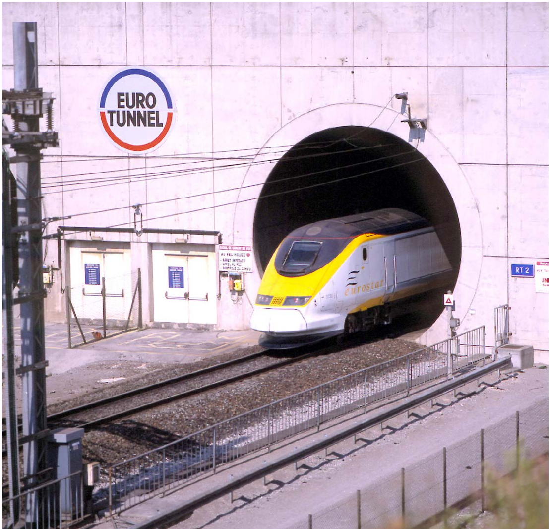
Рис. 2.29. Выходной портал тоннеля
