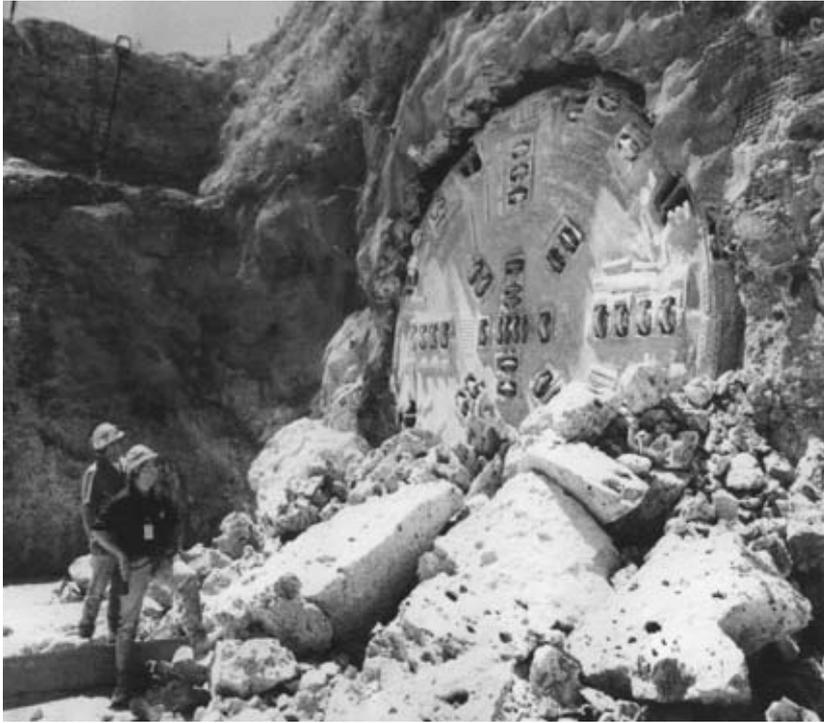
**Рис. 3.11. Окончание проходки разведочного туннеля буровой туннельной машиной**
