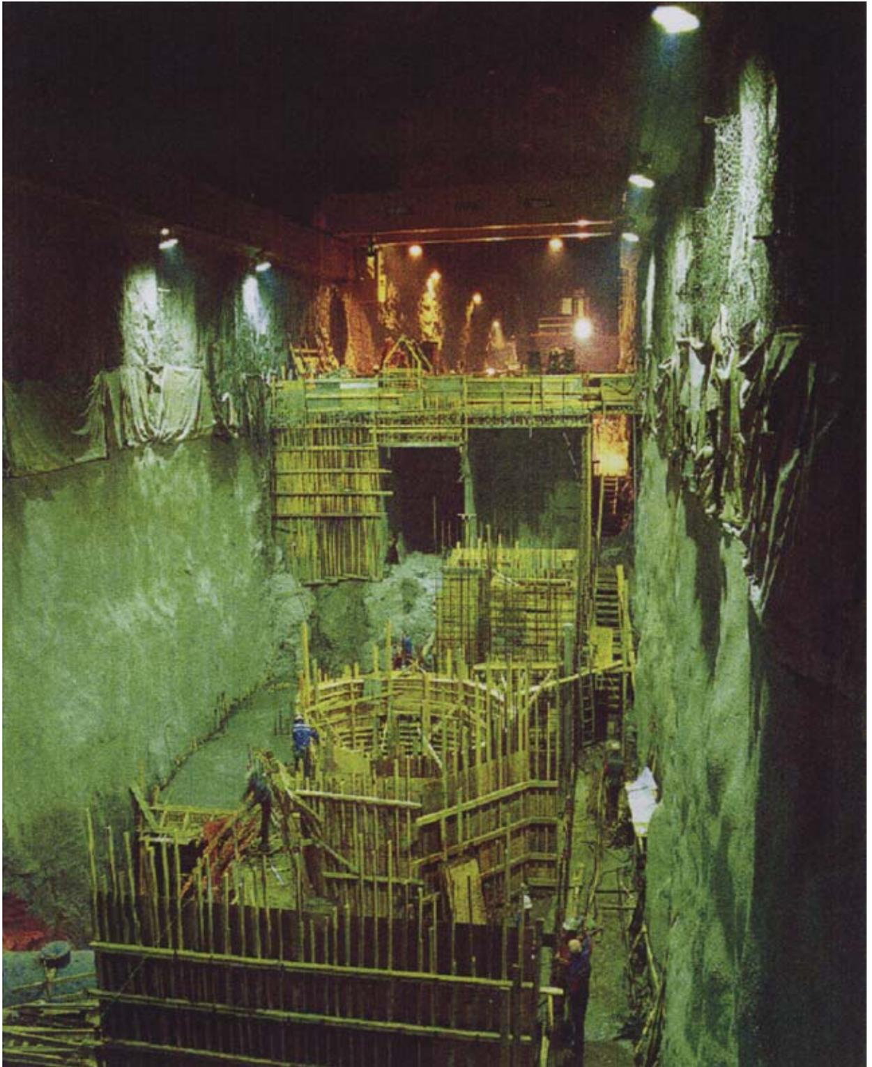
**Рис. 2.51. Строительство главного машинного зала подземной электростанции Нью-Скджерка**
