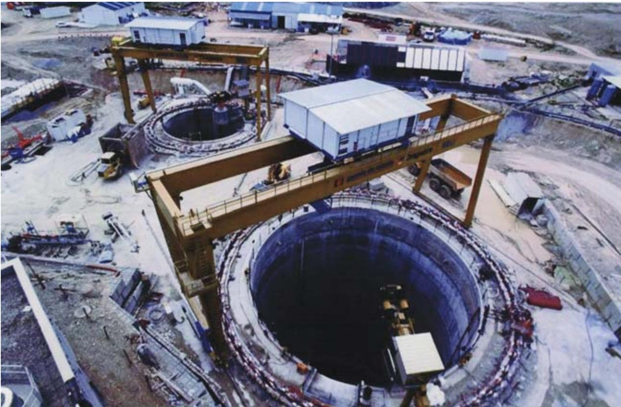
**Рис. 4.100. Вид с поверхности на устье вертикальной шахты**
