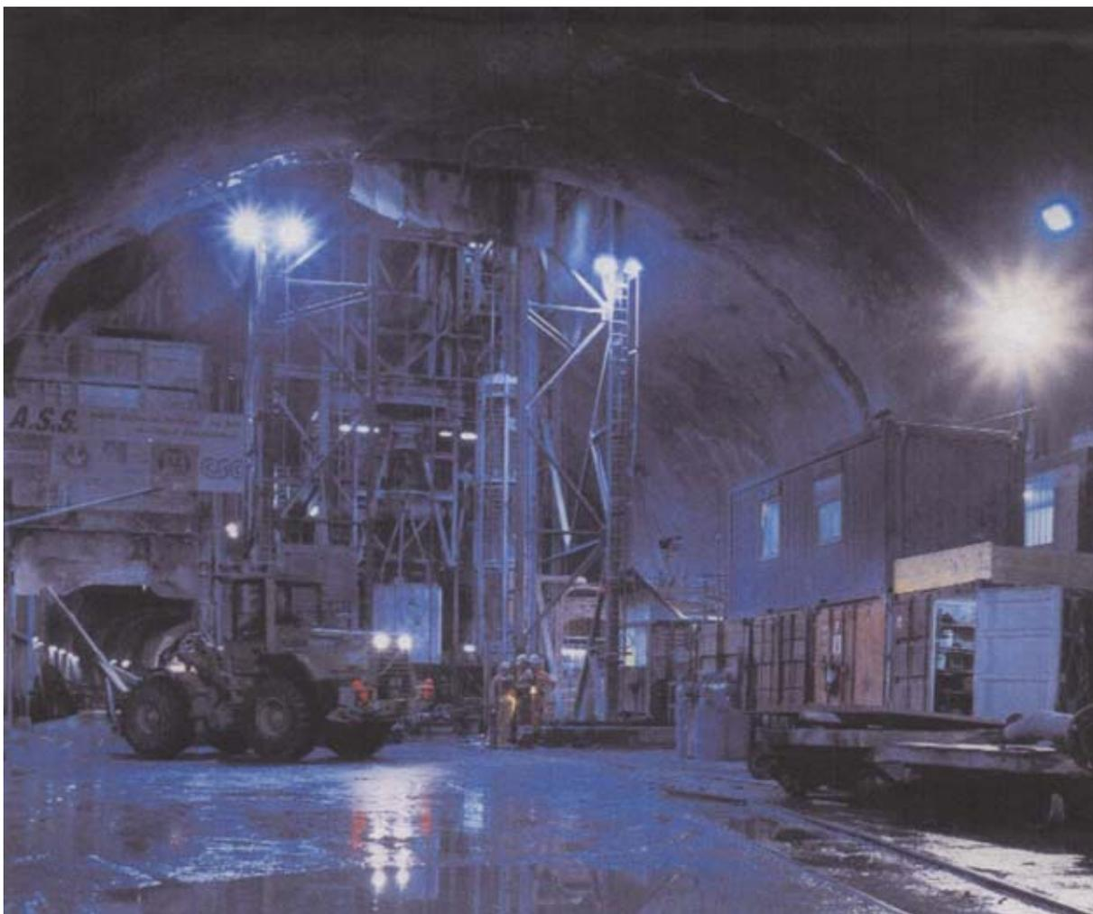
**Рис. 1.18. Окончание формирования арочной кровли подземной выработки**
