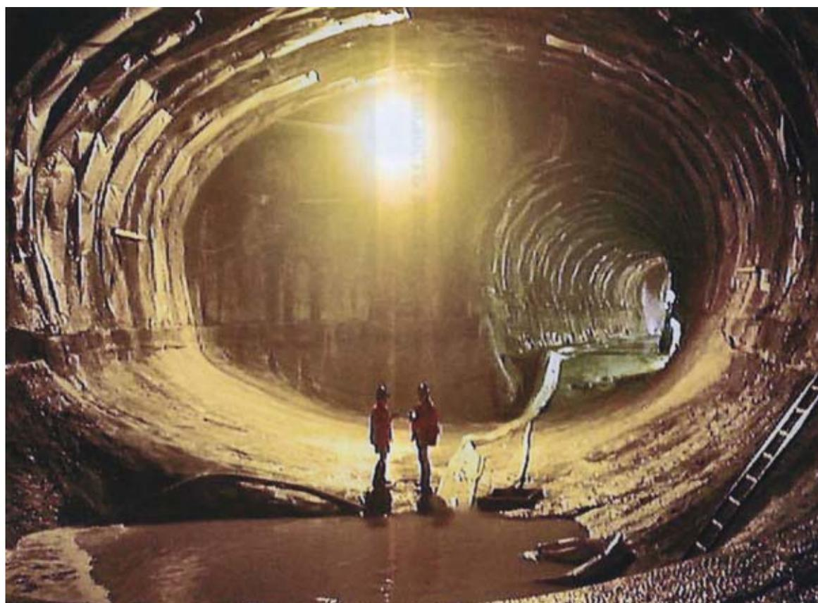
**Рис. 1.17. Подземная полость после проведения взрывных работ**
