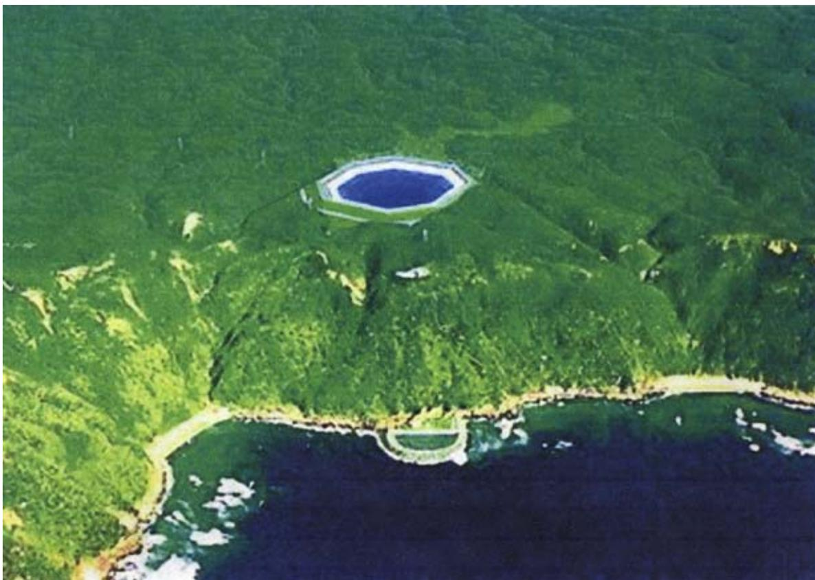
**Рис. 2.39. Поверхностный комплекс гидроэлектростанции Окинава с использованием моря в качестве нижнего резервуара**
