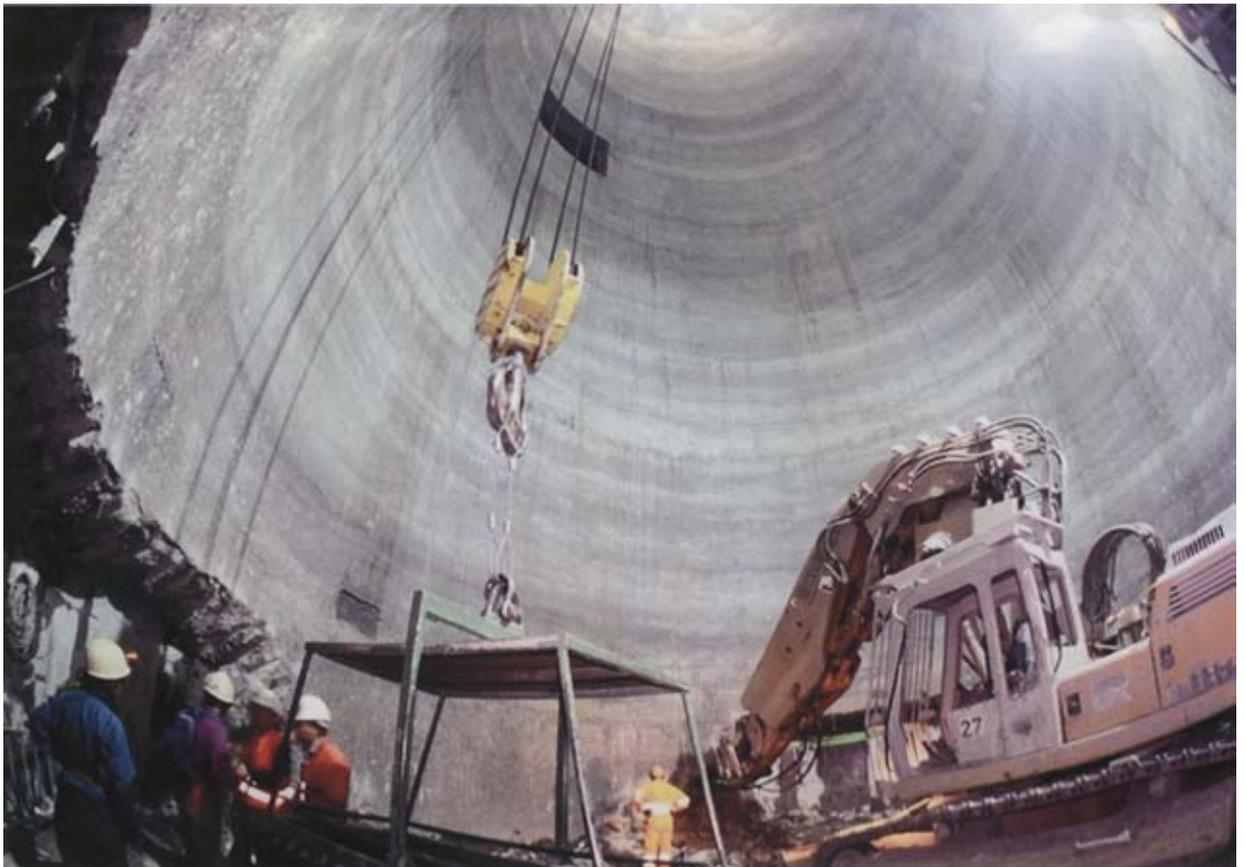
**Рис. 4.102. Сооружение сопряжения вертикальной шахты с экспериментальной полостью**
