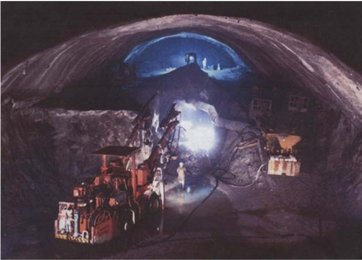
**Рис. 4.88. Проходка полости буровзрывным способом
