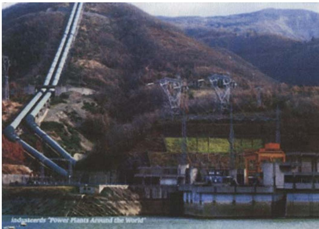
**Рис. 2.42. Поверхностный комплекс электростанции Барги с подачей воды к турбине по стальным трубам**
