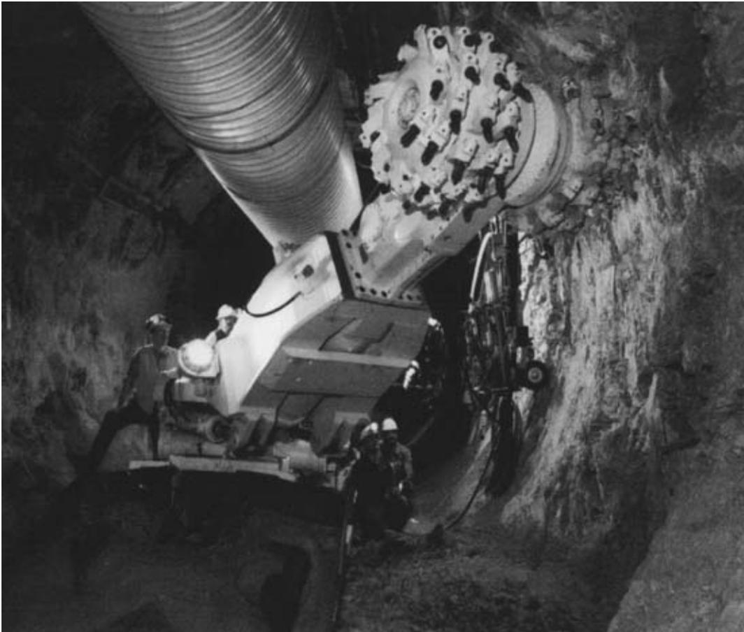
**Рис. 3.12. Проходка ответвлений и ниш туннеля проходческим комбайном**
