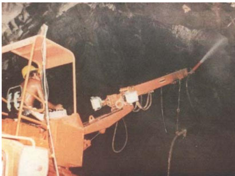
**Рис. 1.23. Работы по нанесению набрызгбетона**
