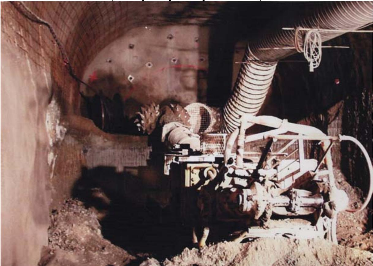
**Рис. 4.89. Проходка полости комбайном (лаборатория Грэн
