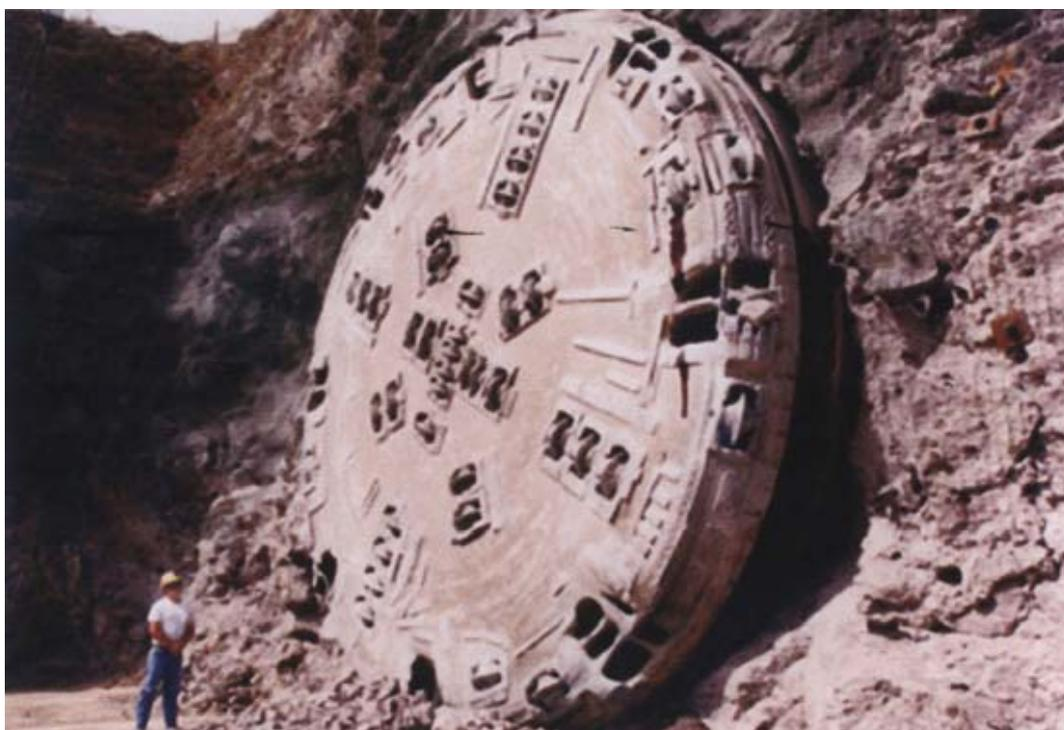
**Рис. 1.25. Выход буровой проходческой машины на поверхность после окончания проходки туннеля ( комплекс хранилища ядерных отходов Юкка-Маунтейн)**
