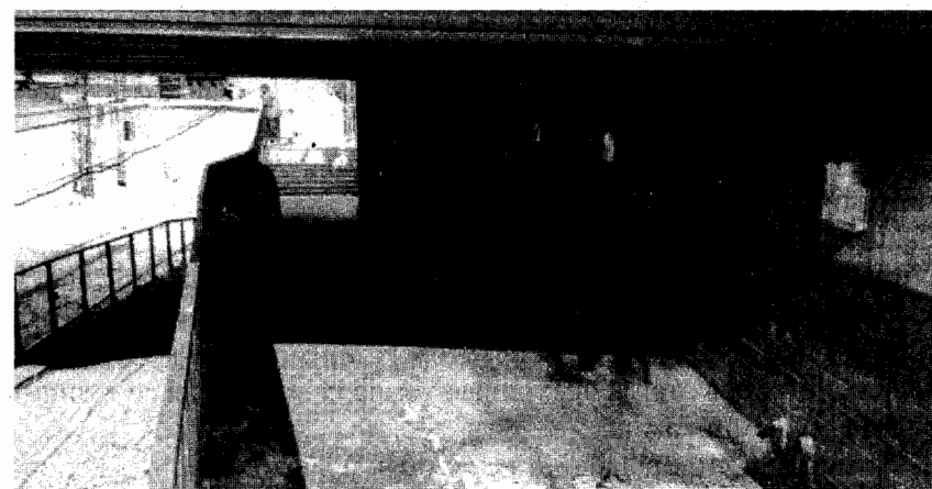
Рис. 2.22. Подмостовой пешеходный переход. Москва
