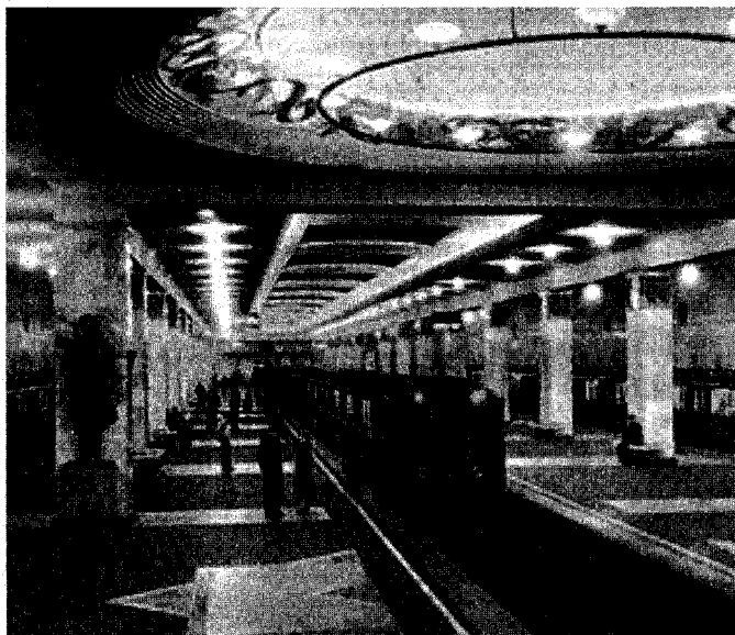
Рис. 1.28. Вид станции «Измайловская» в 1953 году. Круглый светильник с ободком до настоящего времени не сохранился
