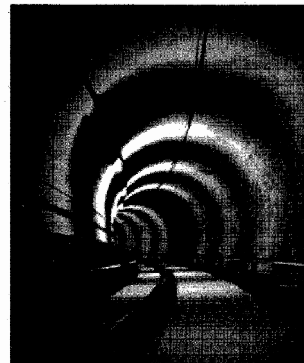
Рис. 2.41 Однопутный перегонный тоннель метрополитена. Гамбург, Германия
