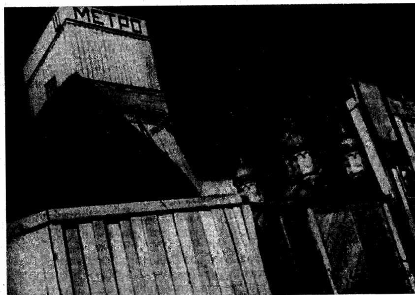
Рис. 1.24. Шахта № 17 кировского радиуса в период строительства. 1932 год
