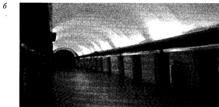
Рис. 2.51 Станции типа «горизонтальный лифт»: а — «Парк Победы», б — «Звёздная». Санкт-Петербург
