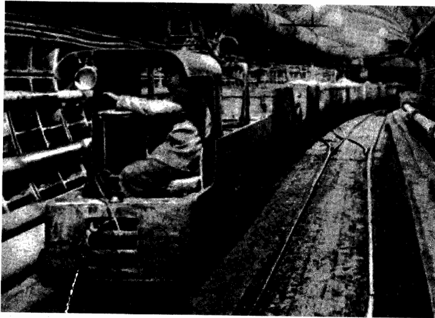
Рис. 1.31. Строительство «Большого кольца» (Кольцевой линии). Электровозная откатка породы
