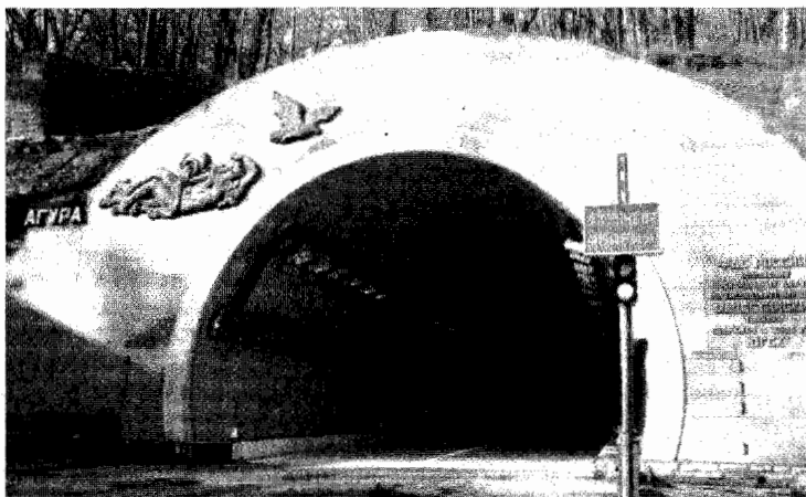
Рис. 2.69. Южный портал Мацестинского автодорожного тоннеля [Луго-ловок, Большкин, 2001]
