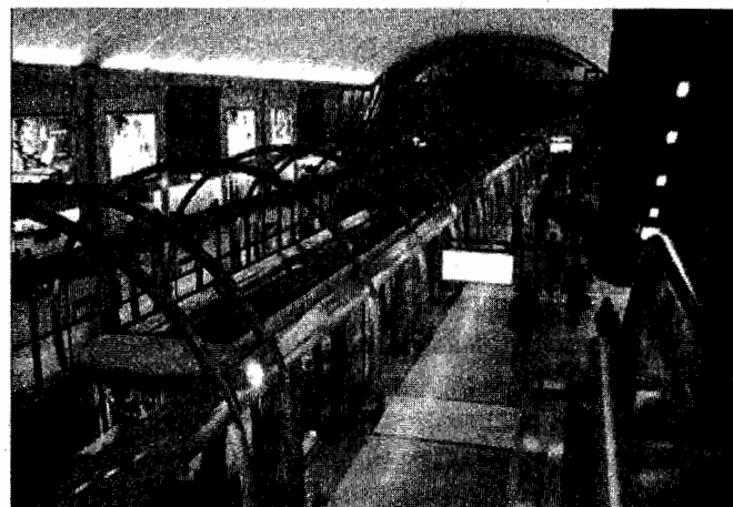
Рис. 3.4. Станция с ограждением платформы из бронированного стекла
